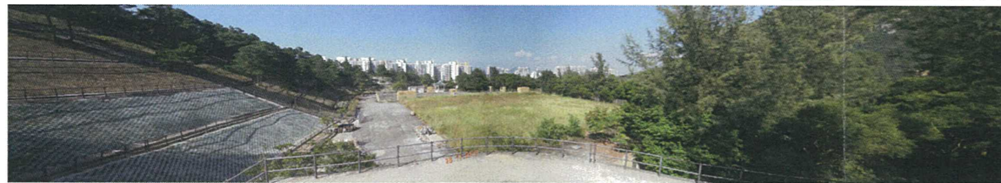
位於 7 9 A 規劃區的現有東涌配水庫 EXISTING TUNG CHUNG SERVICE RESERVOIR IN PLANNING AREA 79A
