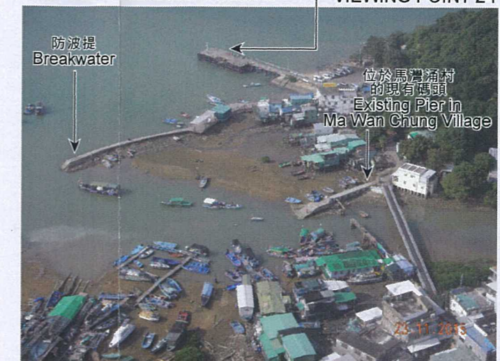
位於馬灣涌範圍的現有碼頭及防波堤 EXISTING PIERS AND BREAKWATER IN MA WAN CHUNG AREA
