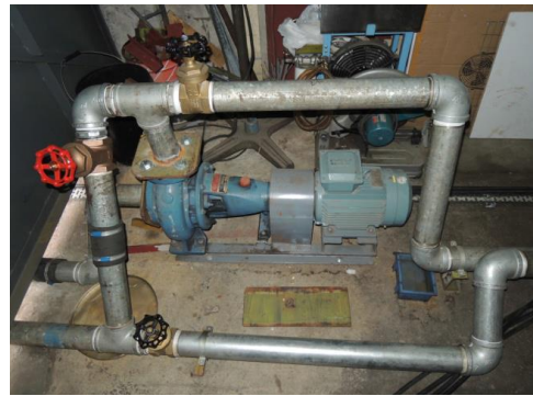
圖 4.4 冷卻發動機之水泵
