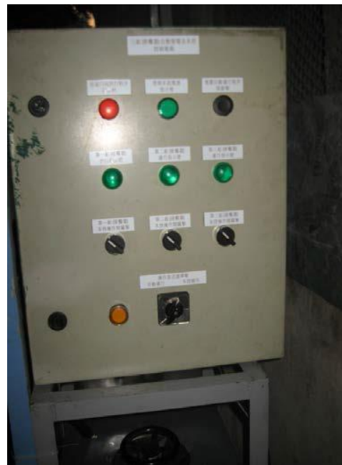
圖 4.6 負載組的 PLC 控制系統
