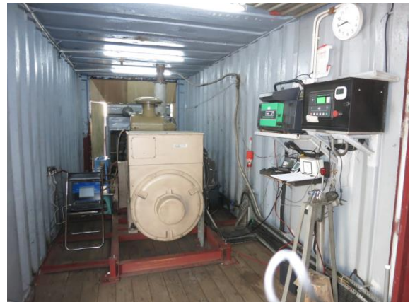
圖 4.8. 發動機裝置在一個 20 英尺的集裝箱
