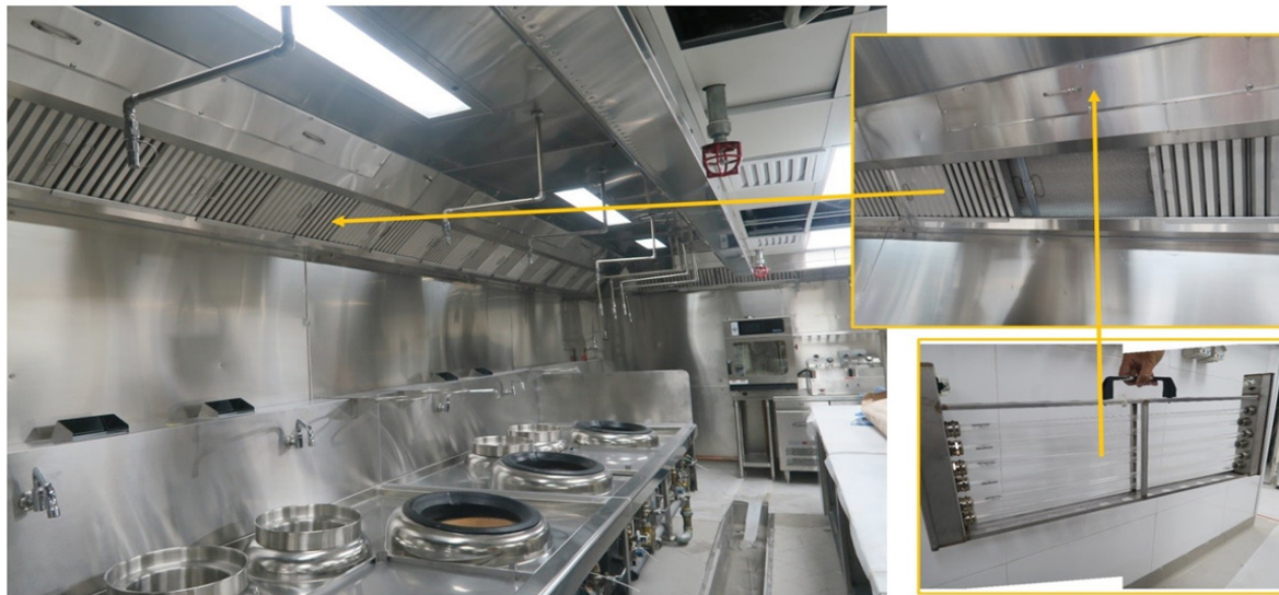
配置紫外線燈的抽油煙罩可去除油煙和氣味
