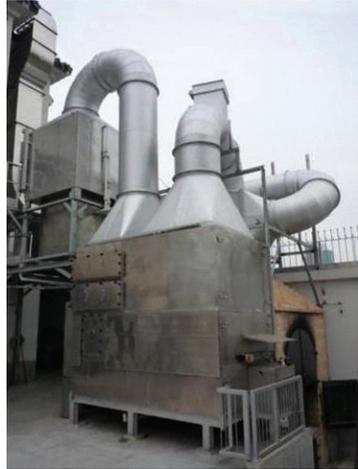
圖3: 採用《最佳可行技術》控制紙紮祭品燃燒爐空氣污染物排放的例子。
