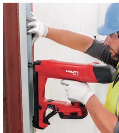
圖2.5 使用充電式釘槍進行固定示意圖 資料來源: 喜利得 5
