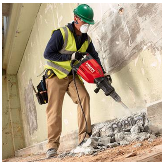
圖2.1 使用風鎬破碎混凝土牆示意圖 資料來源: 喜利得 1
