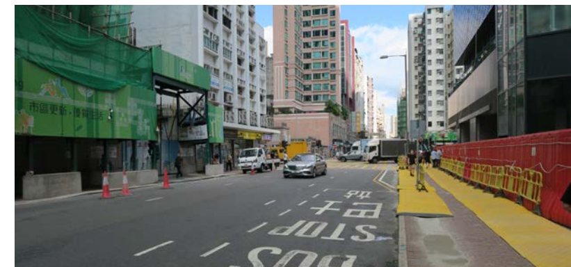
在地區路段中使用 PMSMA6 - 深水埗元州街（由東京街至永隆街）
