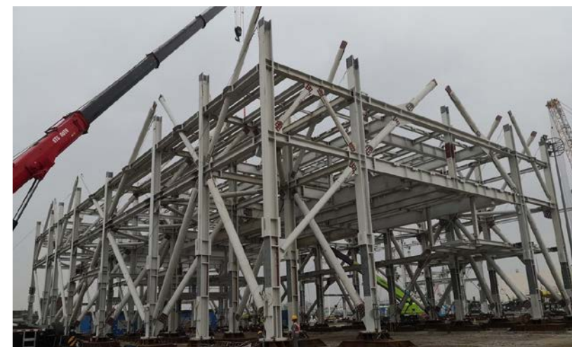
| 在珠海的 I-PARK1 預製場預製機電組件的鋼結構安裝 (2021 年 12 月)
