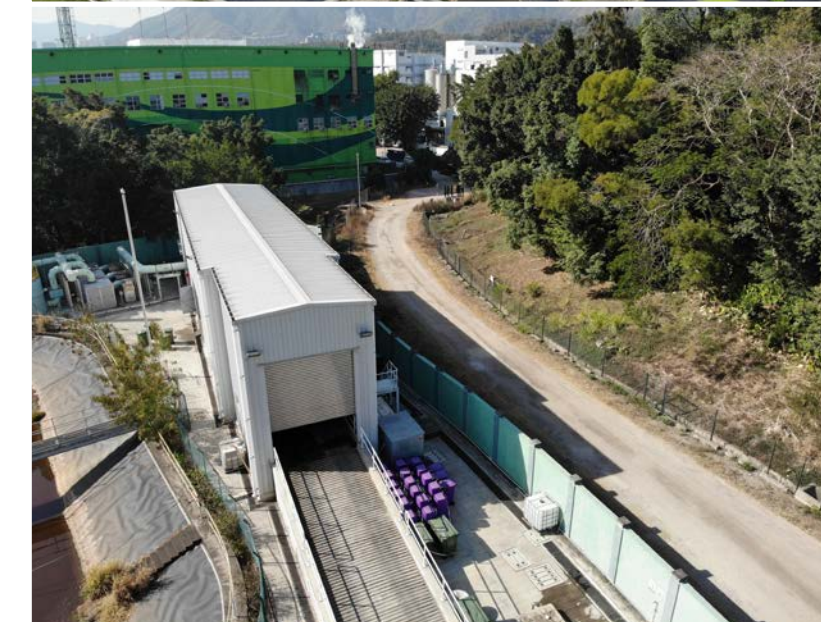
| 用於「廚餘、污泥共厭氧消化」試驗計劃的大埔污水處理廠廚餘預處理設施
