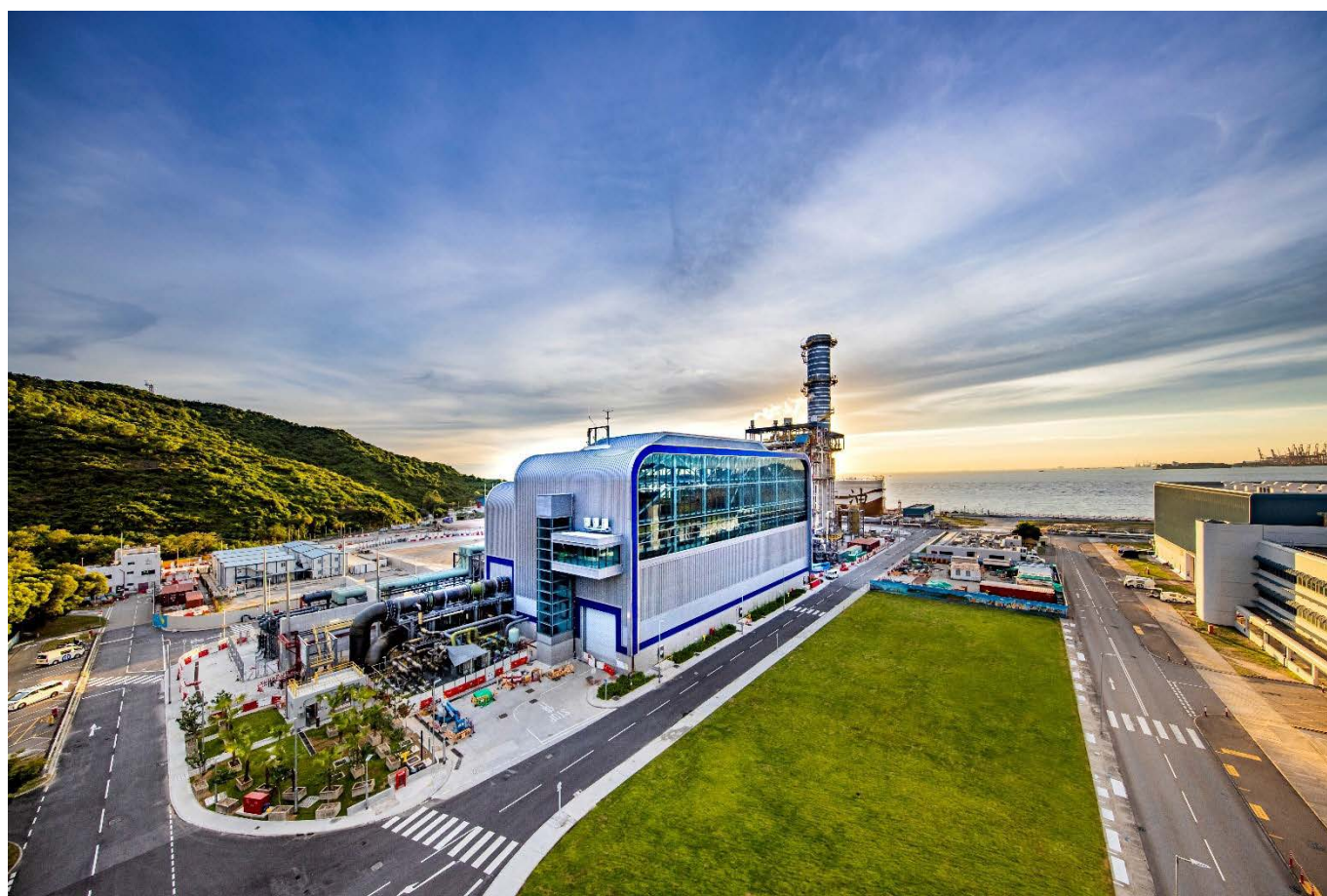
位於龍鼓灘發電廠的新燃氣發電機組
