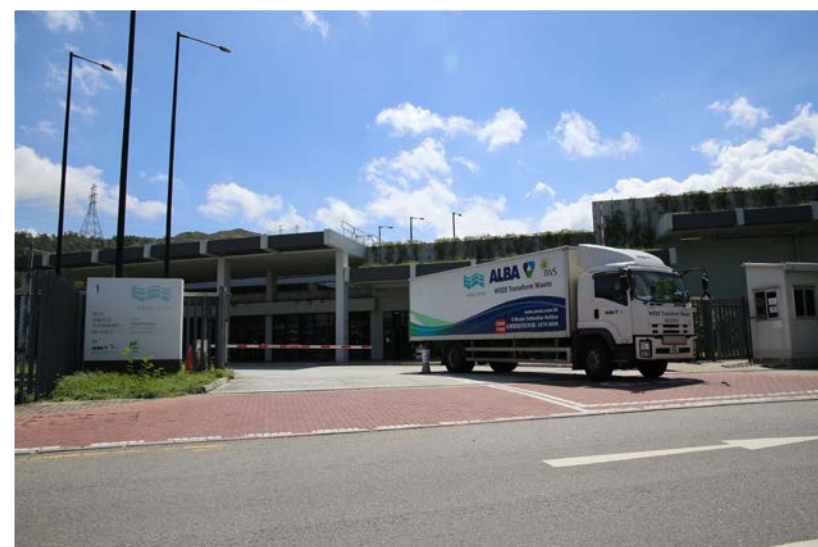
| 廢電器電子產品處理及回收設施 (WEEE-PARK)
