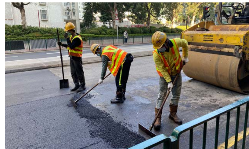
在屯門湖翠路鋪設 PMSMA6 路面
