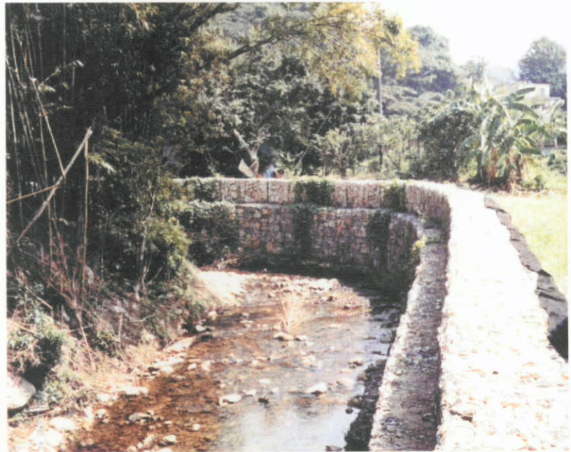
Gabion channel at Pak Ngan Heung, Mui Wo, Lantau
