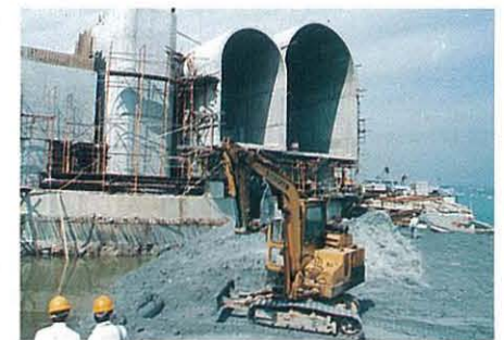
Handling the PFA. 煤灰的處理
