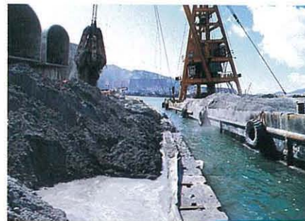
Placing PFA above water level. 在水面上澆注煤灰
