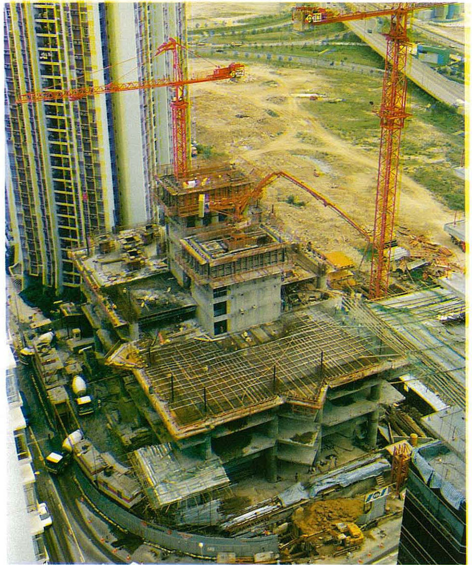
Commencing concrete placement at Cityplaza 3. 太古城中心第三期開始澆注混凝土。
