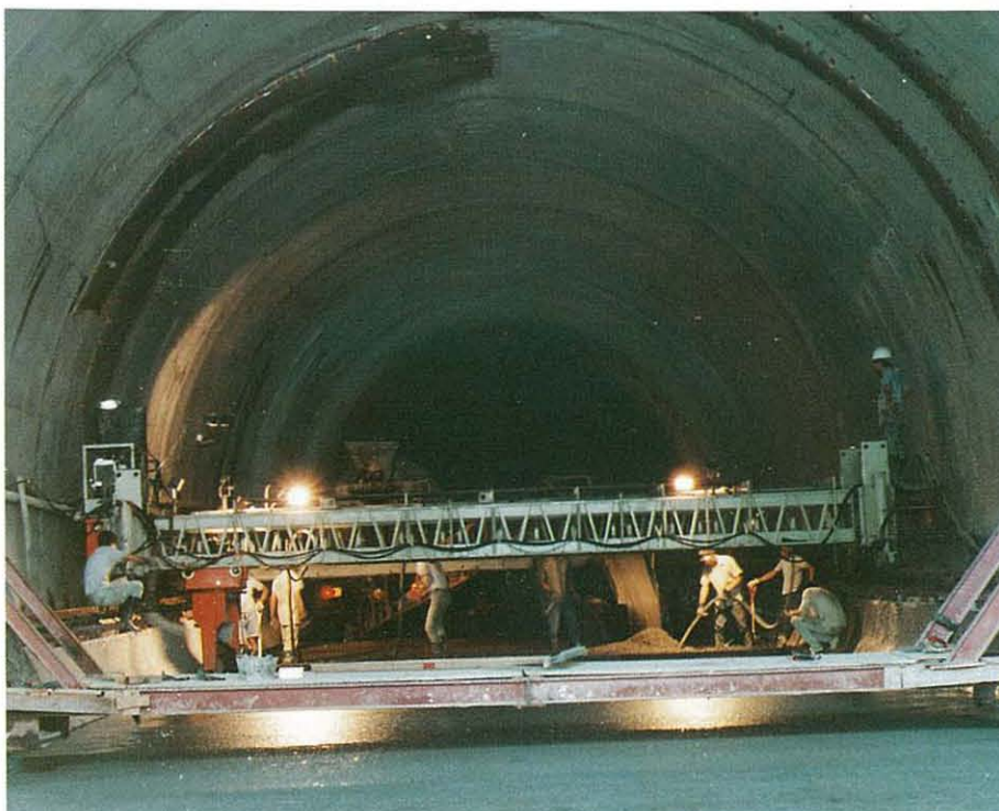
Placing PFA concrete to road pavements 用PFA 混凝土鋪路面。
