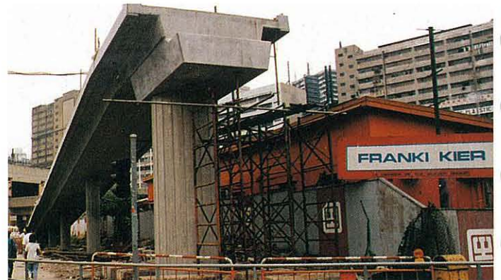
The Kwai Chung Road Flyover used PFA concrete. 煤灰混凝土用於葵涌道天橋
