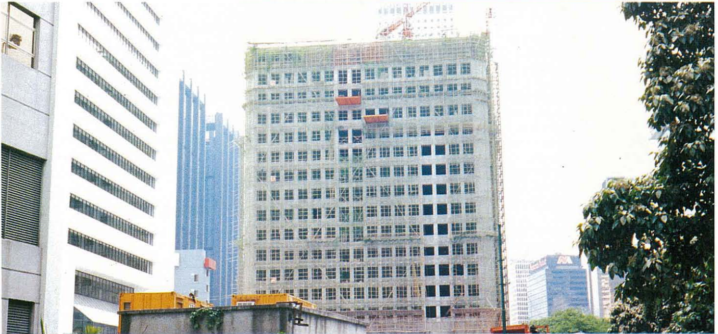
Government Offices under construction. 工程進行中的政府合署
