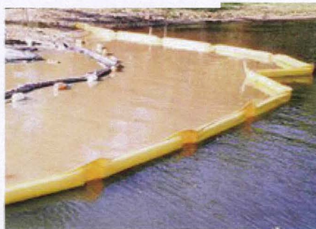
Silt Curtain in Use 使用隔泥幕
